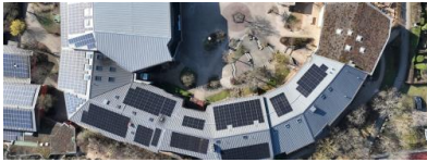
Die PV-Anlage auf der Waldorfschule Ludwigsburg: Die schwarzen Solarmodule (über 670 Quadratmeter) wurden neu installiert, die blauen waren bereits vorhanden. Quelle: SWLB
