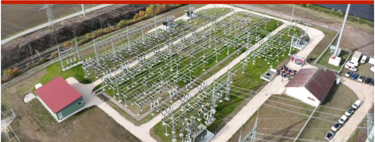
Das modernisierte Umspannwerk bei Winterschneidbach. Quelle: N-Ergie
