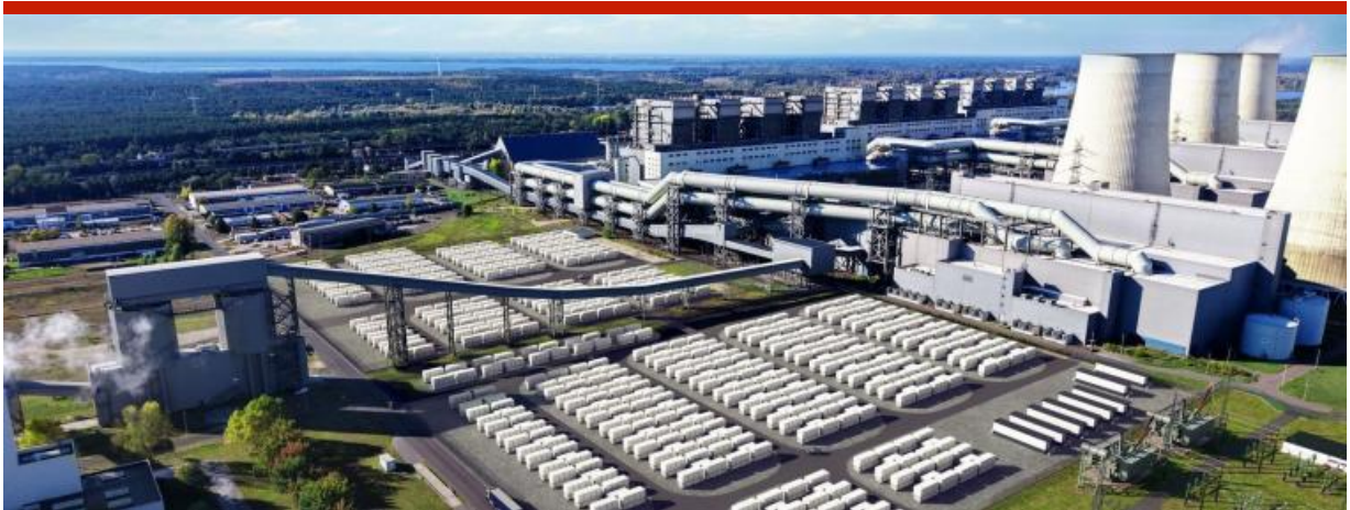
Ein Batteriepark der Superlative entsteht beim Kraftwerk Jänschwalde in Brandenburg. Visualisierung: Leag
