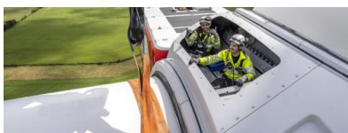
Installation der N175/6.X-Turbine. Quelle: Nordex / Uliche Mertens
