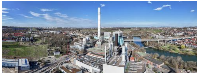
Das wasserstofffähige Gaskraftwerk Stuttgart-Münster. Quelle: EnBW
