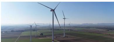
Die beiden neuen Anlagen der Sechs-MW-Klasse sowie die vier noch abzubauenden Anlagen. Quelle: JUWI
