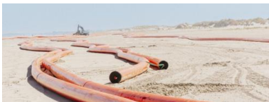
Kabelschutzhöhre am Strand von Norderney für die Offshore-Netzanbindung Dolwin 4. Quelle: Amprion
