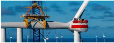
Installationsarbeiten im Nordsee-Windpark Kaskasi. Quelle: RWE
