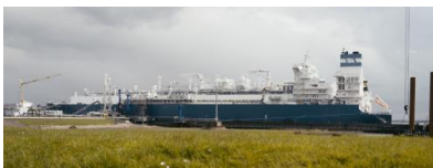
Das LNG-Terminal Brunsbüttel mit Anleger und FSRU. Quelle: DET / Kiekste
