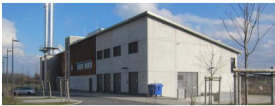
Energiezentrale der Geothermieanlage Unterföhring. Quelle: Geovol
