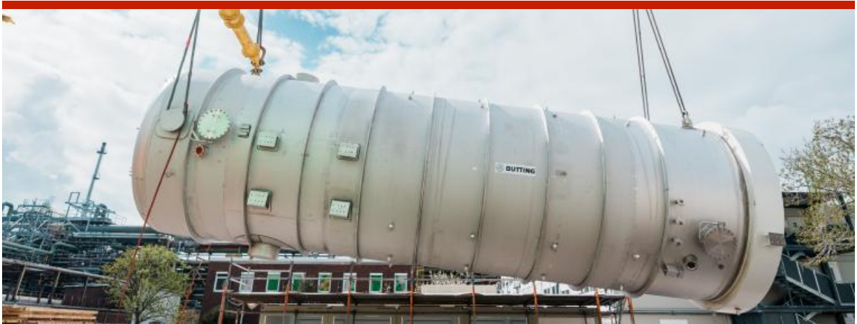
Zwei Kräne heben den fast 100 Tonnen wiegenden Fallfilmverdampfer in die Luft. Quelle: BASF
