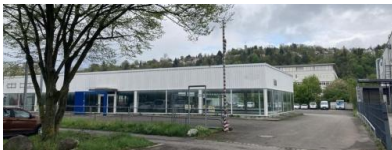
Auf diesem Gelände entsteht ein Ladepark für Elektro-Busse. Quelle: Stadtwerke Tübingen
