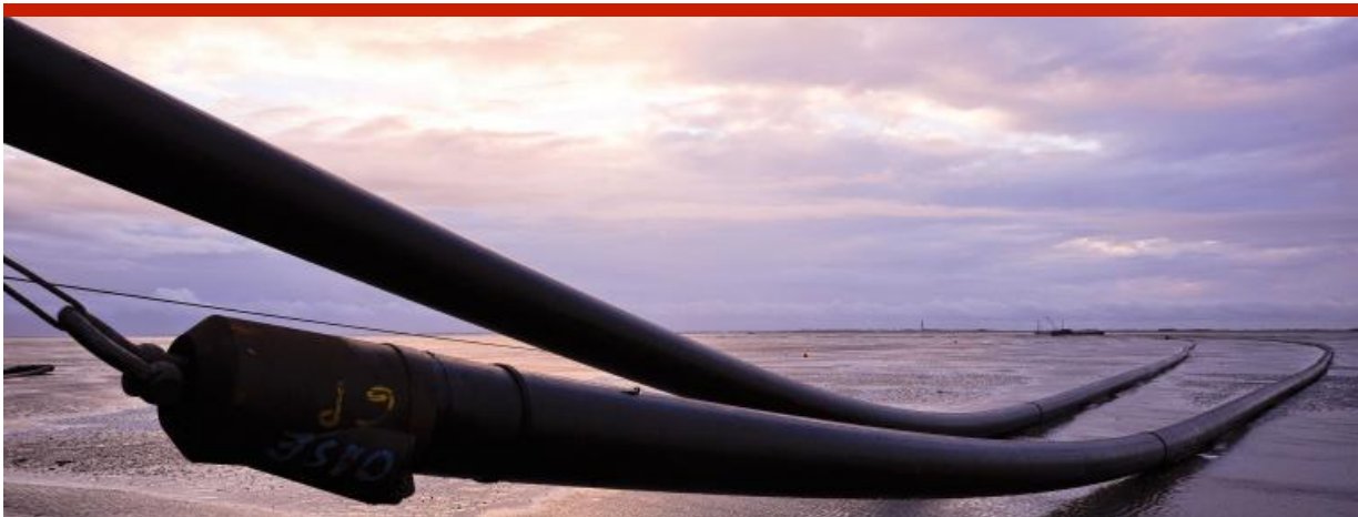
Einbau von Offshore-Kabeln am Nordseestrand. Quelle: Tennet
