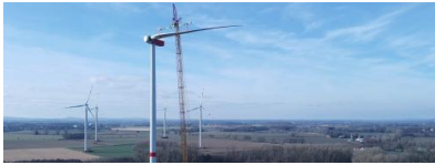
Die Turbine in Lemgo ist inzwischen vollständig errichtet. Quelle: Stadtwerke Münster
