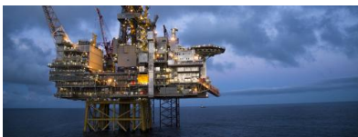
Mit der Anbindung des Eirin-Feldes verlängert sich die Nutzungsdauer der Plattform Gina Krog um sieben Jahre. Quelle: Equinor
