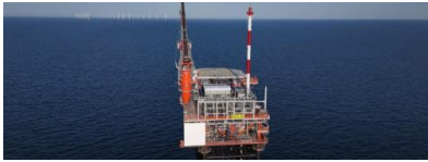
Die Nordsee-Plattform N05-A mit dem Windpark Riffgat. Quelle: ONE-Dyas B.V.
