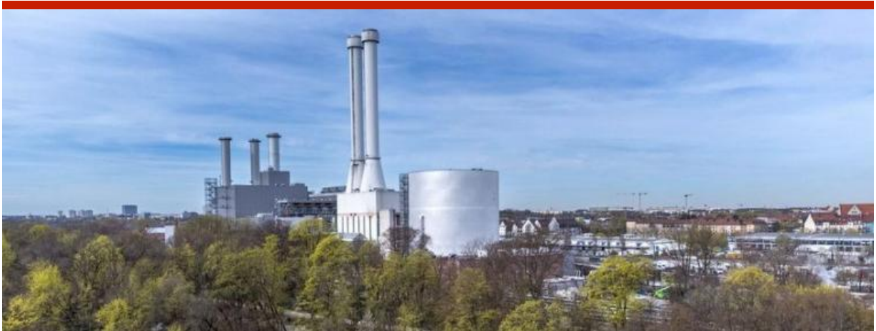
Der Warmwasserspeicher in München Quelle: SWM
