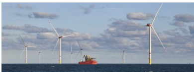
45 von 64 Turbinen im Nordsee-Windpark He Dreiht sind schon installiert. Quelle: EnBW / Rolf Otzipka
