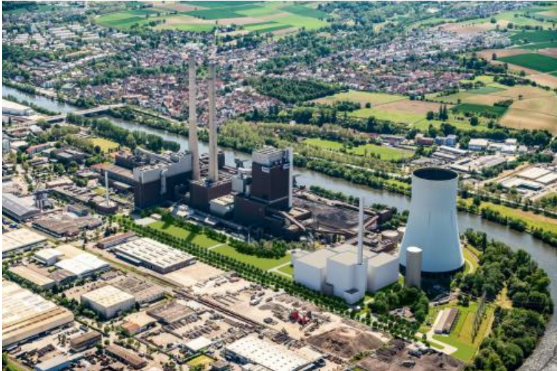
Der Block 7 (Mitte) ist jetzt in der Netzreserve und auf dem Gelände des Kohlekraftwerks Heilbronn entsteht ein Gaskraftwerk (vor dem Kühlturm).
