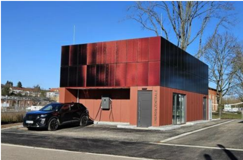
Herzstück der Wärmeversorgung im Quartier: Die Energiezentrale mit markanter roter PV-Fassade Quelle: IG-CP / EnStadt:Pfaff
