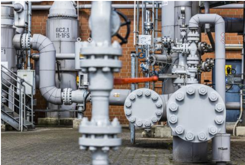
Speicher Lesum in Bremen.
