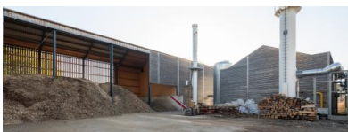
Biomasse-Heizkraftwerk Hungerkamp im Braunschweiger Stadtteil Gliesmarode. Quelle: BS Energy / Nils Hendrik Müller
