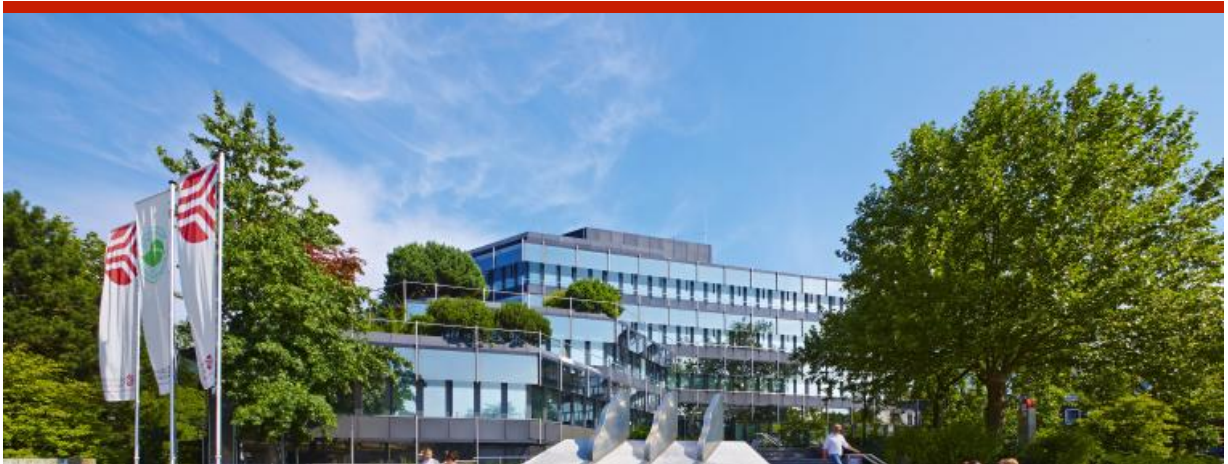
Hauptsitz der Stadtwerke Osnabrück. Quelle: SW Osnabrück
