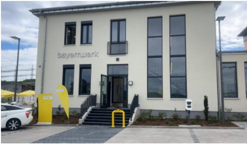
Das neue Schulungszentrum diente früher als Schaltwarte. Quelle: Bayernwerk
