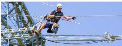
Verstärkung einer 380-kV-Leitung von Tennet bei Erlangen (Bayern) Quelle: Günter Drewnitzky
