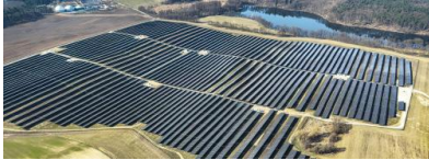
PV-Park Görlsdorf. Quelle: Paul Langrock
