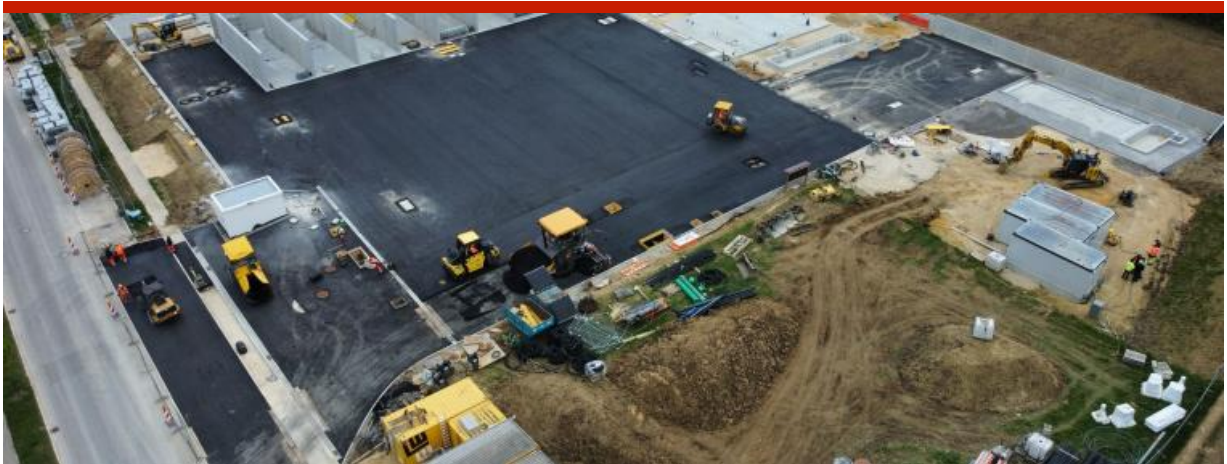
Beispiel einer im Bau befindlichen Wasserstoffproduktionsanlage in Schwäbisch Gmünd. Quelle: Lhyfe
