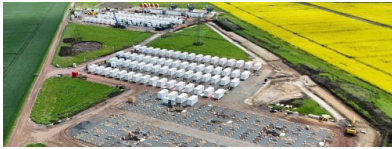
300-MW-Batteriespeicher Förderstedt in der Bauphase. Quelle: Eco Stor
