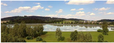
Oberbecken des Speichers. Quelle: Verbund
