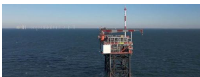
Erdgasplattform N05-A vor Borkum. Quelle: One-Dyas
