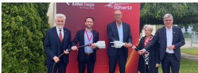
Energeminister Willingmann (links) bei der Inbetriebnahme der Power-To-Heat-Anlage. Quelle: MWU
