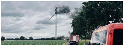
Eine Windkraftanlage in Bönen ist ausgebrannt. Quelle: Feuerwehr Bönen
