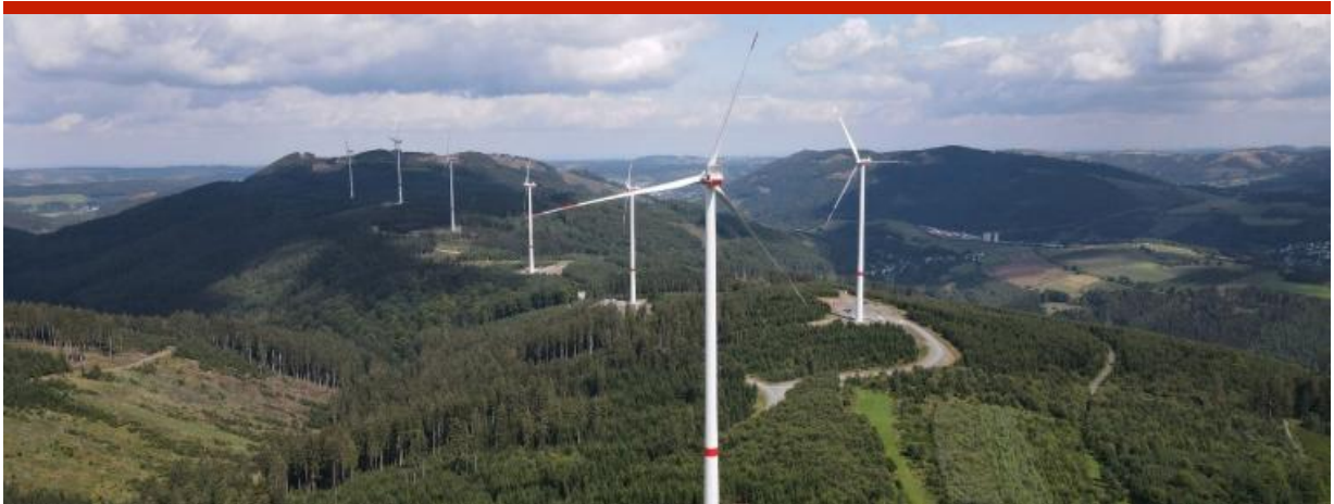
Der Windpark Mannstein in der Gemeinde Olsberg im Hochsauerland. Quelle: MVV
