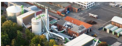
Luftaufnahme des Offenbacher Pelletwerks. Quelle: EVO
