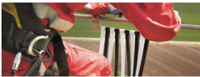
Vogelschutzmarkierungen werden per Hubschrauber angebracht. Quelle: Amprion
