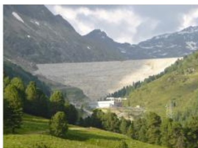
Schüttdamm des Pumpspeicherkraftwerkes Kühtai 2 Quelle: Klaus Fischer
