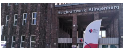
BEW-Heizkraftwerk Klingenberg in Berlin. Quelle: Susanne Harmsen
