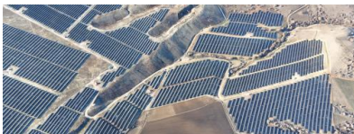
PV-Projekt Amynteo 2 in Griechenland. Quelle: RWE
