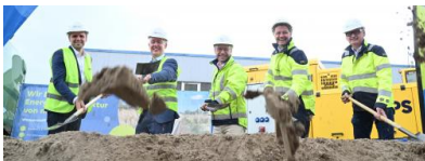
Spatenstich der H2Coastlink 1. Quelle: EWE Netz / Carina Penning
