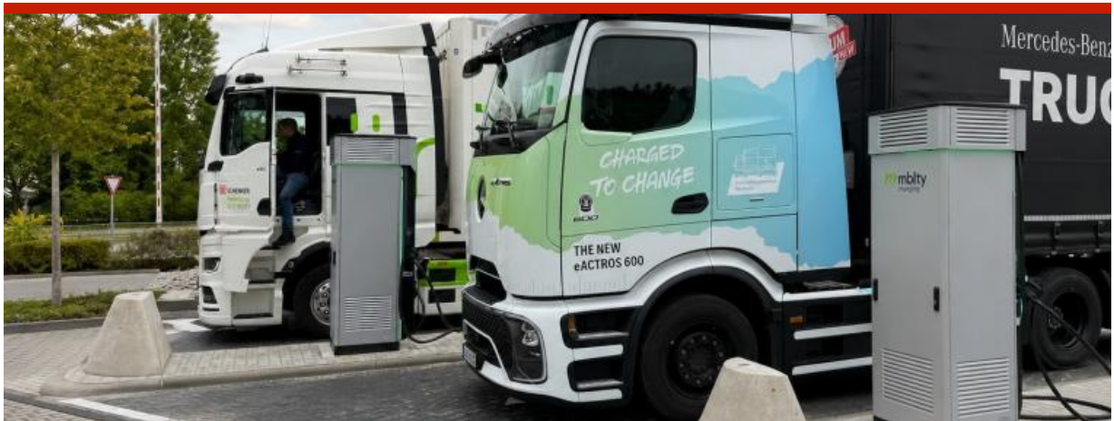
Ladestation für Elektro-Lkw. Quelle: Tank & Rast
