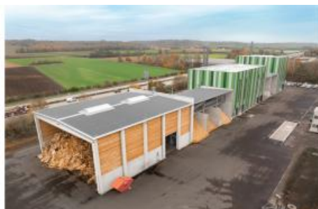
Teil des Biomasseheizwerk Dingolfing an der A92 Quelle: Schmidmeier Naturenergie
