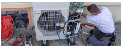
Einbau einer Wärmepumpe. Quelle: Shutterstock / JPC-PROD
