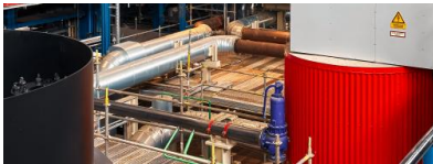
Die zweite Power-to-Heat-Anlage in Herrenhausen im Bau Quelle: Enercity
