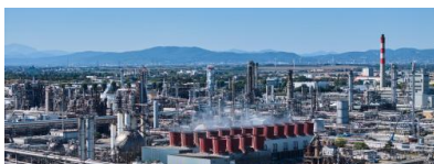
Die Raffinerie Schwechat bei Wien. Quelle: OMV AG
