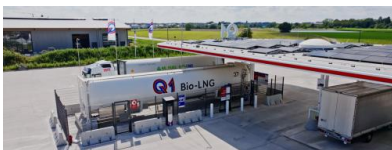
Bio-LNG-Tankstelle in Iffezheim. Quelle: Q1 Energie AG
