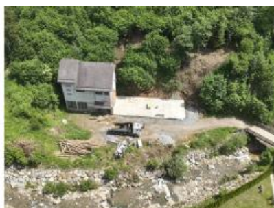
Vorbereitungen für die Installation der ersten Batteriespeicher
