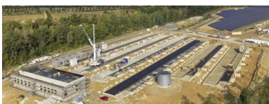
Im Tagebau Hambach entsteht ein Batteriespeicher. Quelle: RWE
