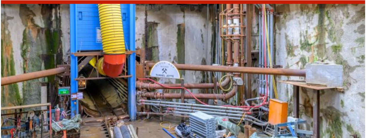
Baustelle des Übersee-Tunnels ElbX in Wewelsfleth. Quelle: Tennet Germany
