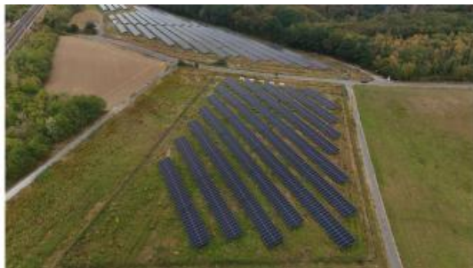
Der Solarpark Görgeshausen Quelle: Sascha Ditscher / EVM
