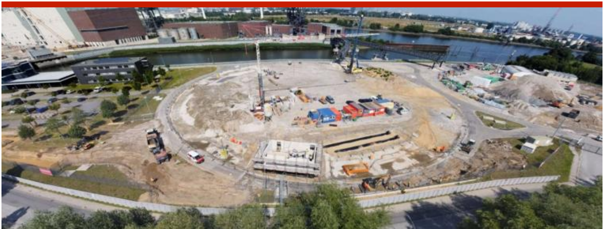
Baustelle aus der Vogelperspektive. Quelle: Hamburger Energienetze
