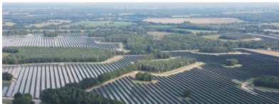
Solarpark Halenbeck-Rohlsdorf II. Quelle: DAL Deutsche Anlagen-Leasing / Denis Sherlizyn
