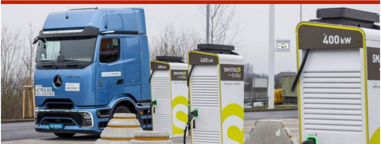
Ladepark in Regau mit E-Lkw an Ladesäule. Quelle: Smatrics EnBW
