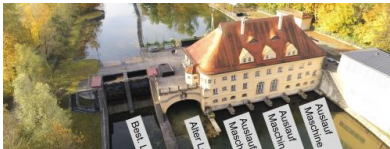
Das Wasserkraftwerk Isar 1. Quelle: SWM
