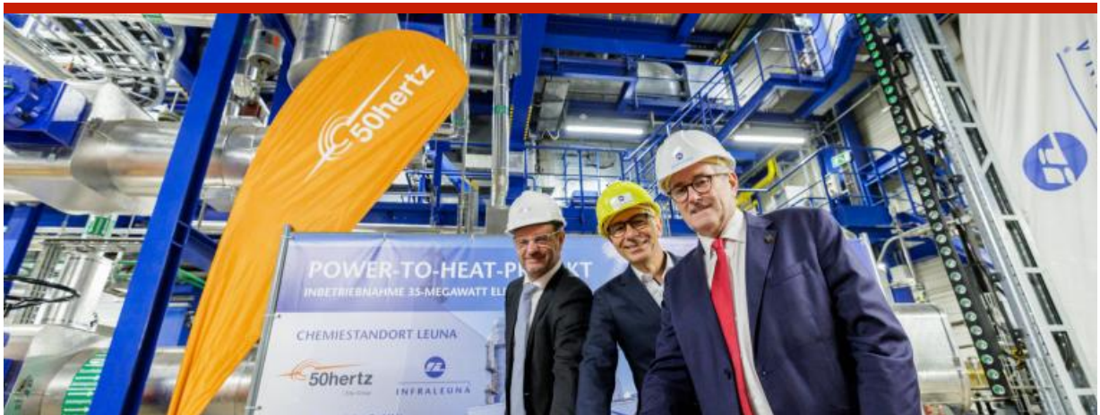
v.l.: Stefan Kapferer, CEO 50 Hertz, Christof Günther, CEO InfraLeuna und Jürgen Ude, Staatssekretär für industrielle Großprojekte Sachsen-Anhalt, bei der Inbetriebnahme des 35-Megawatt-Elektrodenkessels. Quelle: InfraLeuna
