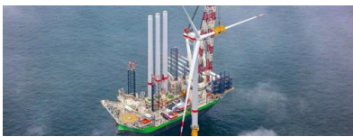
Installation am Nordseecoluster A. Quelle: RWE
