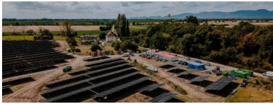
Die Stromkundschaft legt Geld im Solarpark Benzenloch an. Quelle: Stadtwerke Neustadt
