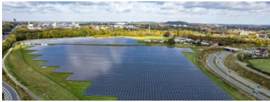
Der Kerkrade-Solar-Park in der niederländischen Provinz Limburg versorgt Air Products mit Grünstrom zur Wasserstoffherstellung. Quelle: RWE
