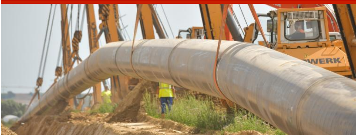
Absenken des Rohrstrangs der Süddeutschen Erdgasleitung (SEL), mit der die neuen Gaskraftwerke versorgt werden sollen. Quelle: Terranets BW
