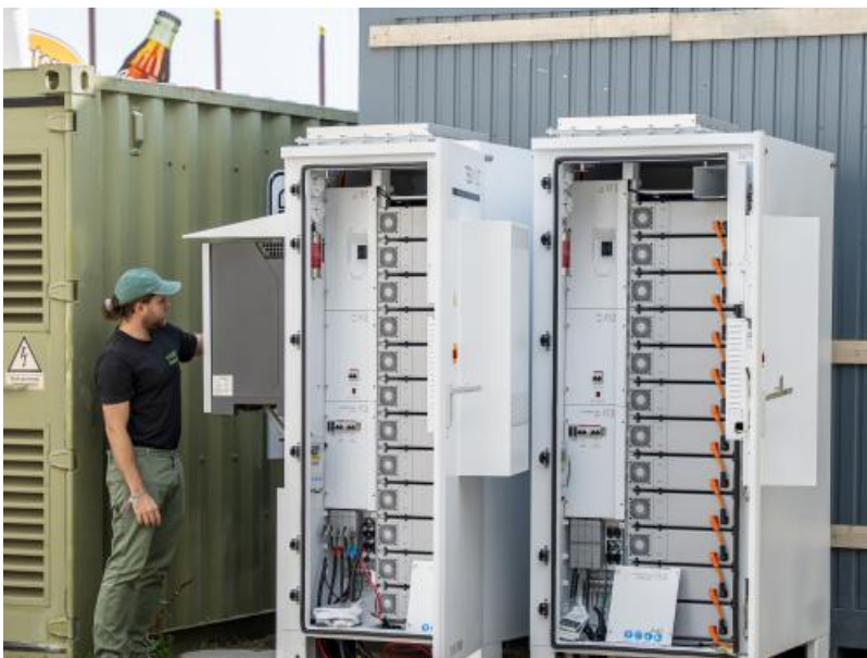
Zwei Forton-Speicher kappen Lastspitzen im Pschorr-Bräurosl Festzelt, einer kommt im Löwenbräu-Zelt zum Einsatz.
