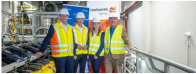
Im Heizkraftwerk: Michael Maxelon, Martin Giehl, Martina Butz und Claus Kaminsky. Quelle: Mainova AG
