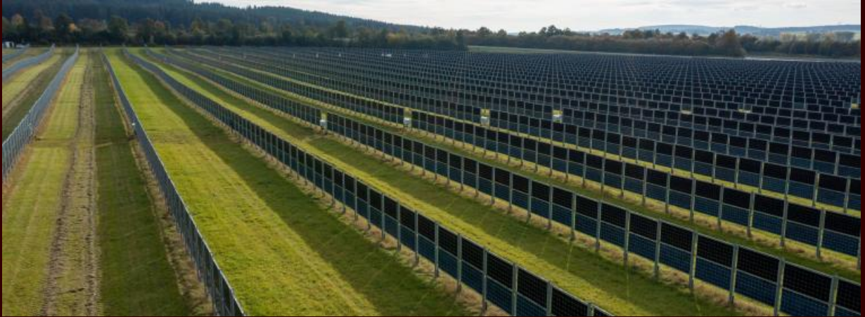
Agri-Solarpark Donaueschingen. Quelle: Next2Sun
