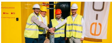
Baustart des Klinikums Memmingen. Bereits die Baustelle erhält Fernwärme. Quelle: e-con AG
