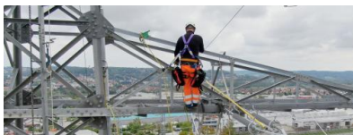
Arbeiten am Verteilnetz. Quelle: Bayernwerk / Christian Poppe
