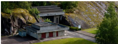
Kraftwerk Sima in Eidfjord im Westen Norwegens. Quelle: Voith
