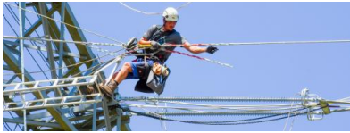
Verstärkung einer 380-kV-Leitung von Tennet. Quelle: Günter Drewnitzky
